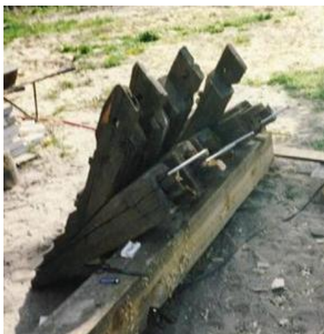
Nowe złącza rozciągane więźby kościółka w Łaszewie.
