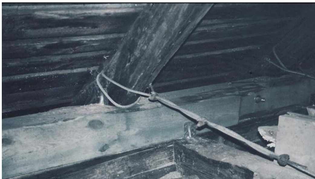
Lina przejmująca rozpór więźby kościoła w Tarnowie Pałuckim.
