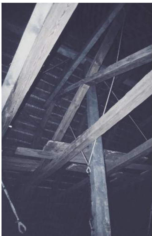
Lina przejmująca rozpór więźby kościoła w Tarnowie Pałuckim.
